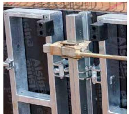
El sistema de unión de los paneles se realiza mediante la grapa rápida y manual GR-2, utilizada en los sistemas de Alisply Muros, Alisply Pilares y Alisply Universal.
