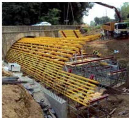
Concebido para adaptarse fácilmente a geometrías complejas en la construcción de viaductos, pasos inferiores y pasos superiores, manteniendo su condición de encofrado recuperable.
