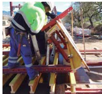
Una de las premisas en el diseño ha sido dotarle, una vez ensamblado, de una alta rigidez, lo que facilita enormemente el desencofrado y posterior traslado para una nueva puesta, que se traduce en una alta productividad en la obra.
