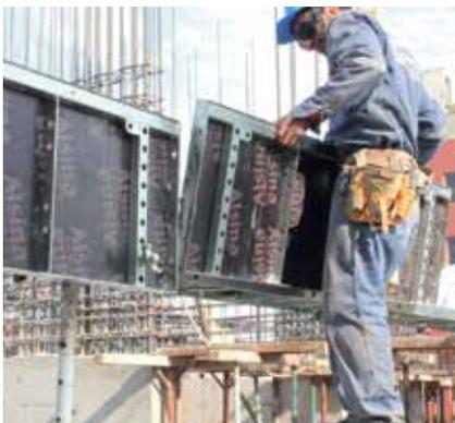
A diferencia de otros sistemas de panel, el sistema se basa en la resolución de diferentes medidas de cuelgue con el mismo panel lateral.
