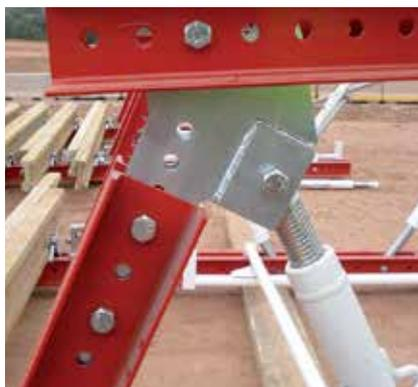
La estructura que forman las vigas primarias metálicas y las vigas secundarias de madera permiten configurar la pantalla en relación a la carga que deberá soportar, optimizando así los elementos y los costes.
