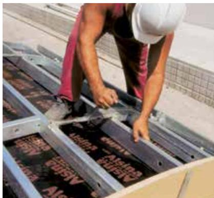
El diseño del panel incorpora los elementos necesarios y no se necesita herramientas especiales.
