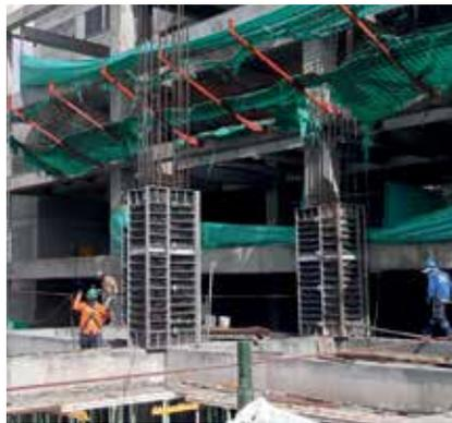
Un sistema de unión fácil y rápido; con un sólo golpe de martillo se consigue la fijación de la cuña y el bulón, quedando el conjunto de los paneles perfectamente ensamblado.
