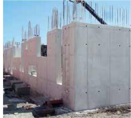
Proporciona un acabado de hormigón visto y posibilita el definir la textura de este mediante la colocación de elementos de fácil adhesión al forro.
