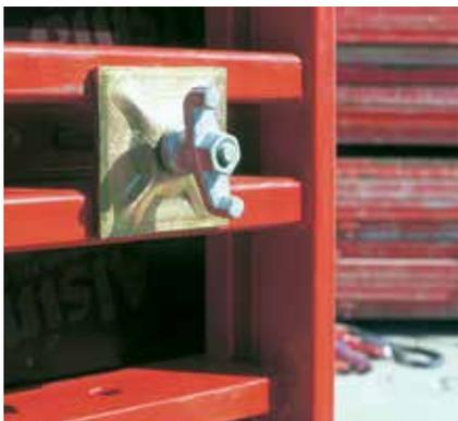
Para la unión entre los paneles a reducción se utiliza el Espárrago Alisply Universal y la Placa Tuerca Palomilla Alisply.
