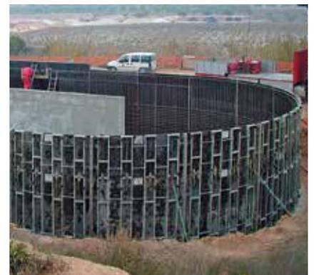
Los módulos se adaptan a cualquier radio necesario en la obra, por lo tanto sirven para diferentes tipos de muro curvo.
