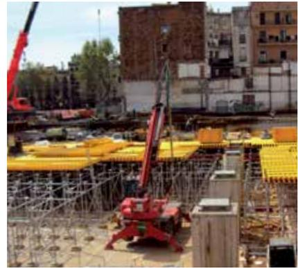
El sistema Vistaform permite la distribución de las vigas y el apeo de acuerdo con el peso de la losa a ejecutar. También facilita el encuentro con muros y vigas de cuelgue al poder solaparse las vigas de madera entre sí.
