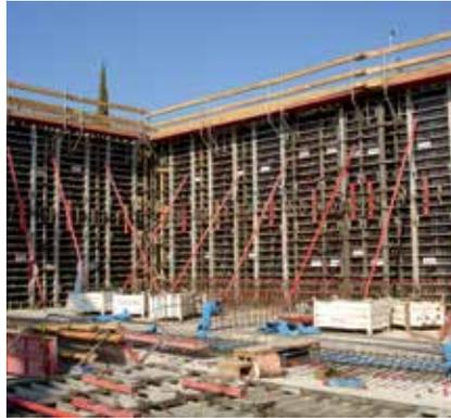
El Sistema Alispaly Muros, así como sus accesorios, están diseñados para un montaje rápido y fácil. El apoyo del marco de 15 cm facilita el ensamblaje y alineación de los paneles.
