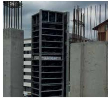
Realmente ligero y resistente. Posibilita el montaje manual sin necesidad de grúa. Reducción de peso, un 25% menor que otros sistemas, pero manteniendo una presión admisible de 80 kN/m<sup>2</sup>.
