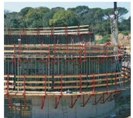
Los módulos se adaptan a cualquier radio necesario en la obra, por lo tanto sirven para diferentes tipos de muro curvo.
