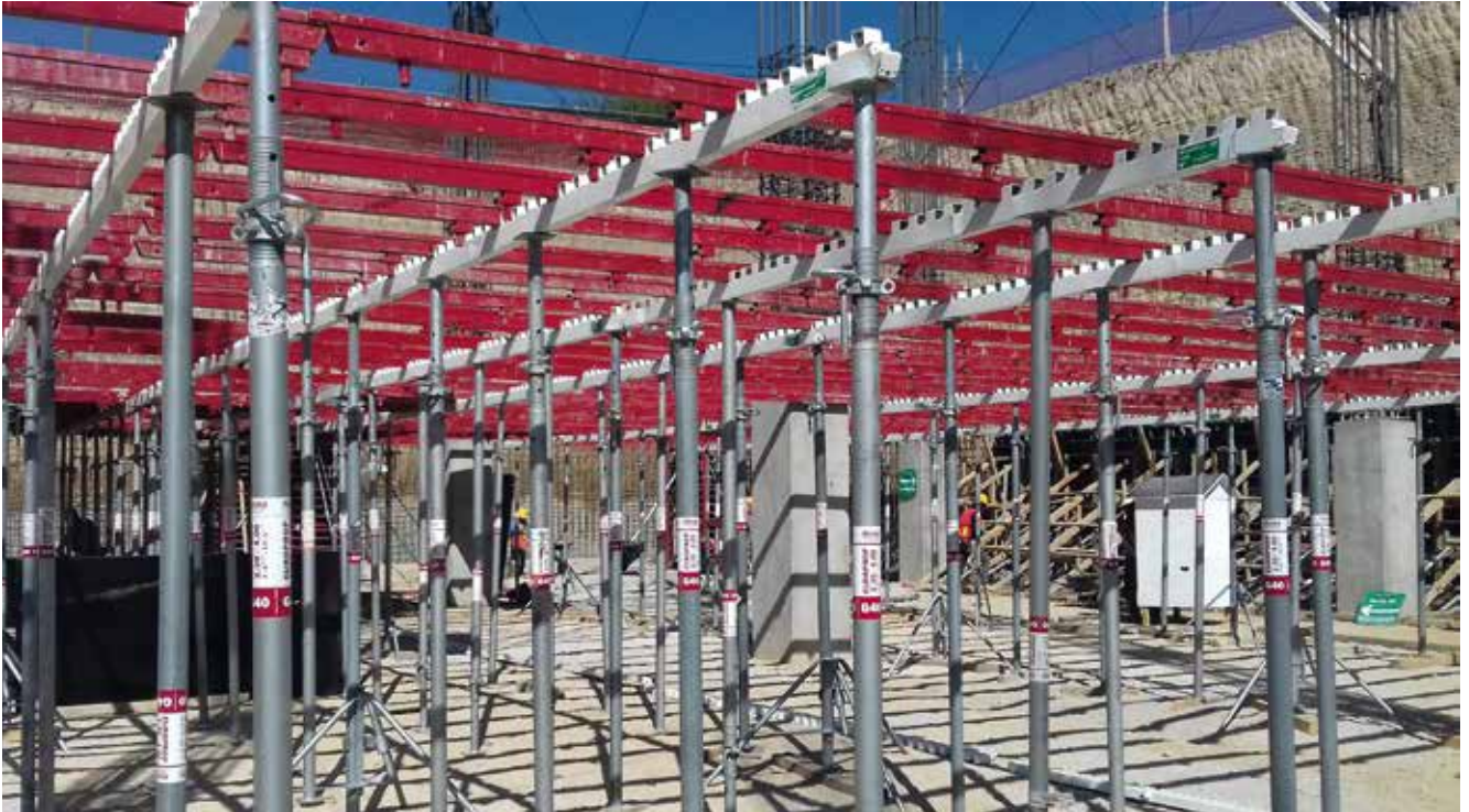
Edificio Office Park 4A Jalisco, México
