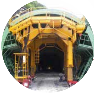
Encofrado de túneles
