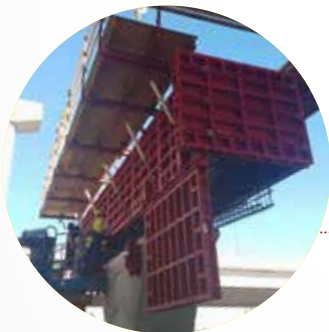
Pilas y dinteles de hormigón
