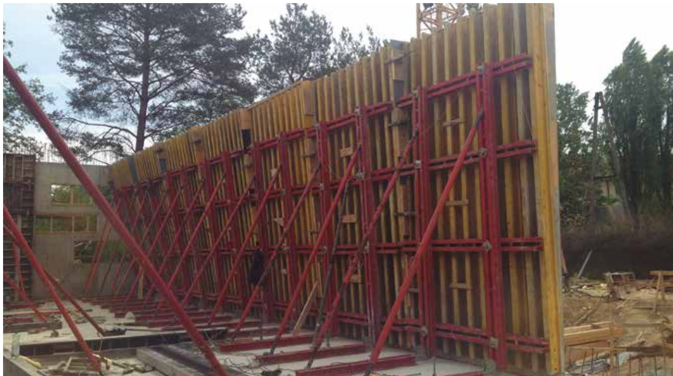
Centru de Date din Varșovia, Polonia
