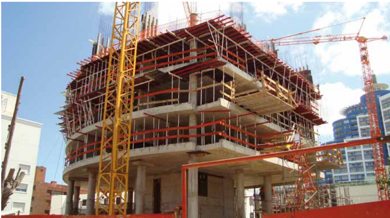
Edifício Alexander, Uruguai
